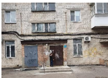
Фото. Відсутність урн біля багатоквартирних будинків
