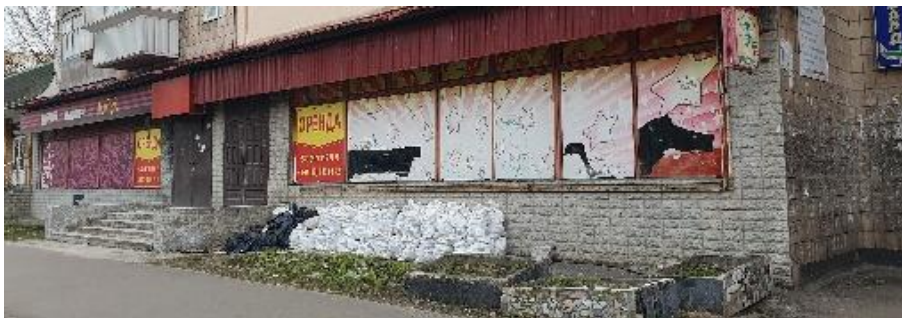
Фото. Збирання ремонтних відходів у виділених місцях
